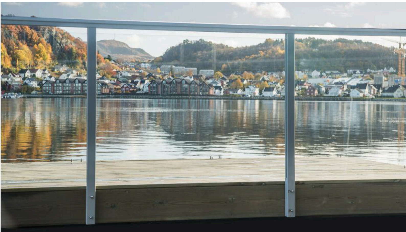
Brage festet på utside dekkekant
