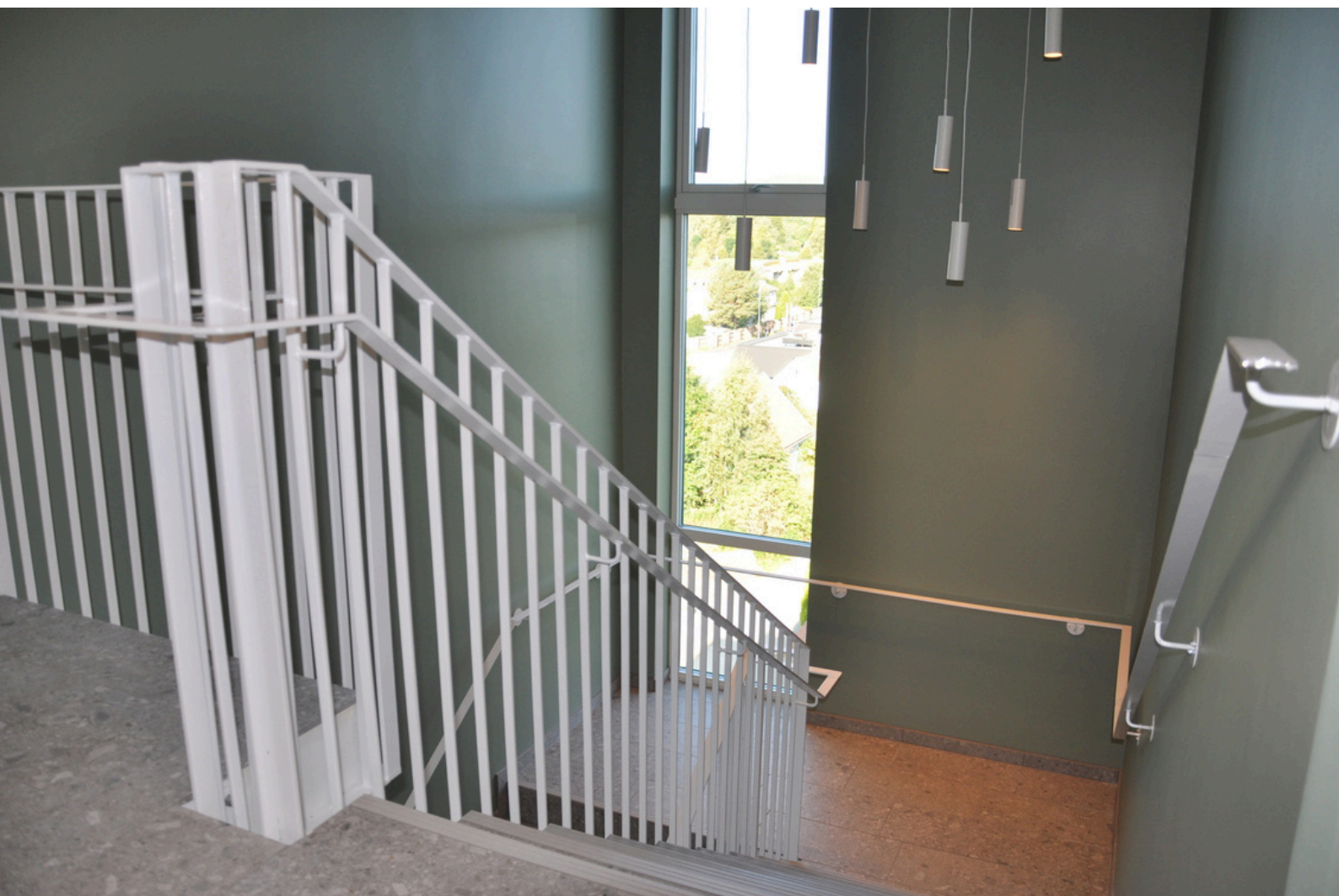
Arkitekt tegnet spilerekkverk i stål
